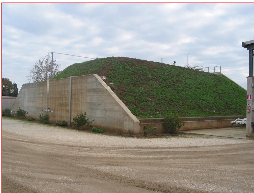
Fig. 2.1- Serbatoi tumulati della capacità di 200 mc cadauno
