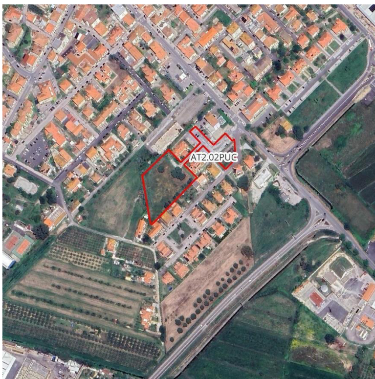
Figura 5-7: Area di trasformazione AT2.02PUC - COMPLETAMENTO RESIDENZIALE.
