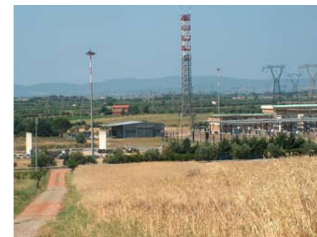
esempio di Tessuto specialistico F5 - infrastrutture e impianti tecnologici di interesse generale - Loc. Forni Suvereto
